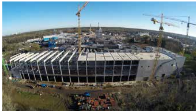
Neubau Papierfabrik SCHOELLERSHAMMER
